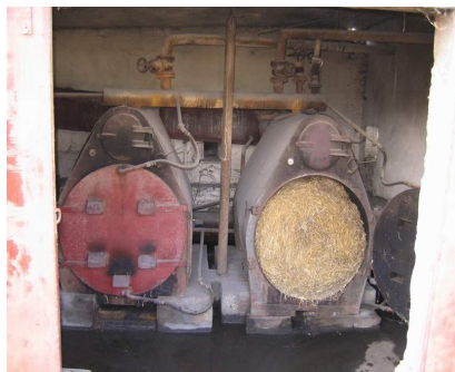
Rys.6. Kotły na słomę w Dakowach Mokrych
